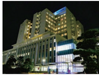
旭中央病院本館
