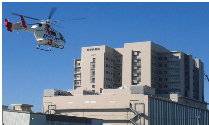
当院は敷地内にヘリポートを設置し、ドクターヘリや消防・防災ヘリなどによる搬送患者さんの受け入れも行っていきます
